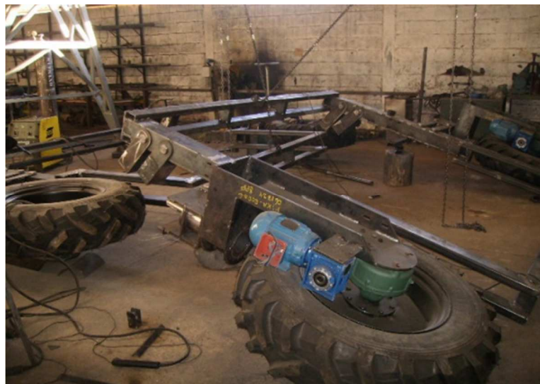
FIGURA 1.25 Montagem da lateral de chassi e do pantográfico definitivo
