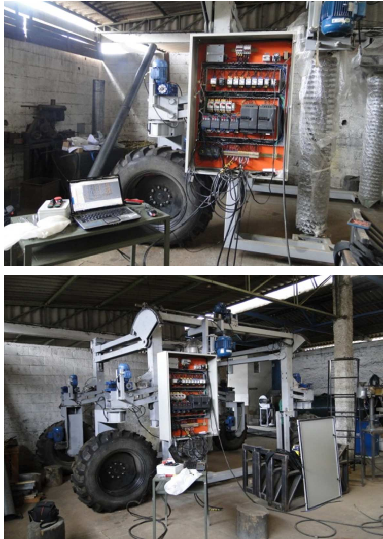
FIGURA 1.30 Montagem do painel elétrico e do controle remoto via cabo.
