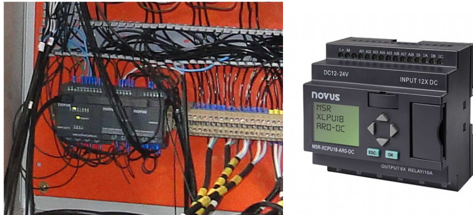
FIGURA 2.05 Controlador lógico programável Novus modelo NSR.
