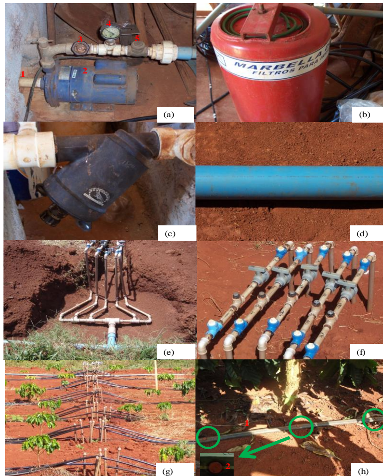
Figura 1 Sequência de ilustrações apresentando detalhes do sistema de irrigação utilizado no experimento: (a 1 ) sucção afogada de 1 ¼"; (a 2 ) moto-bomba centrífuga de 3 cv; (a 3 ) registro de gaveta de 1"; (a 4 ) manômetro; (a 5 ) válvula de retenção 1"; (b) filtro de Areia de 16"; (c) filtro de disco 1 ½"; (d) tubos de PVC azul DN 50 e PN 40 (linha principal); (e) tubos e registros nas linhas de derivação que conduzia a água até as linhas laterais das três repetições de cada nível de adubação; (f) individualização dos cinco níveis de adubação por meio de registros nas linhas de derivação de umas das áreas do experimento; (g) distribuição das linhas laterais; (h 1 ) linhas laterais com tubo flexível de polietileno de 16 mm, PN 40 e (h 2 ) gotejadores Katiff autocompensantes, vazão de 3,75 L h -1
