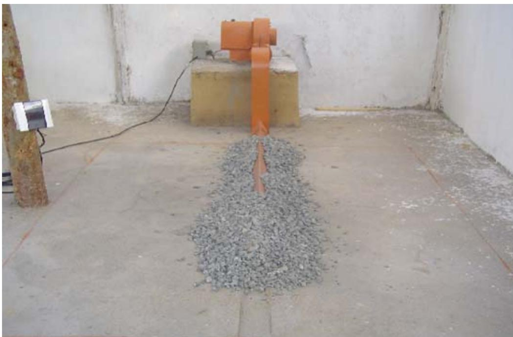
Figura 3.6. Detalhamento da camada de brita colocada sobre o duto de aeração e, ao fundo observa-se o duto interligado ao ventilador.
