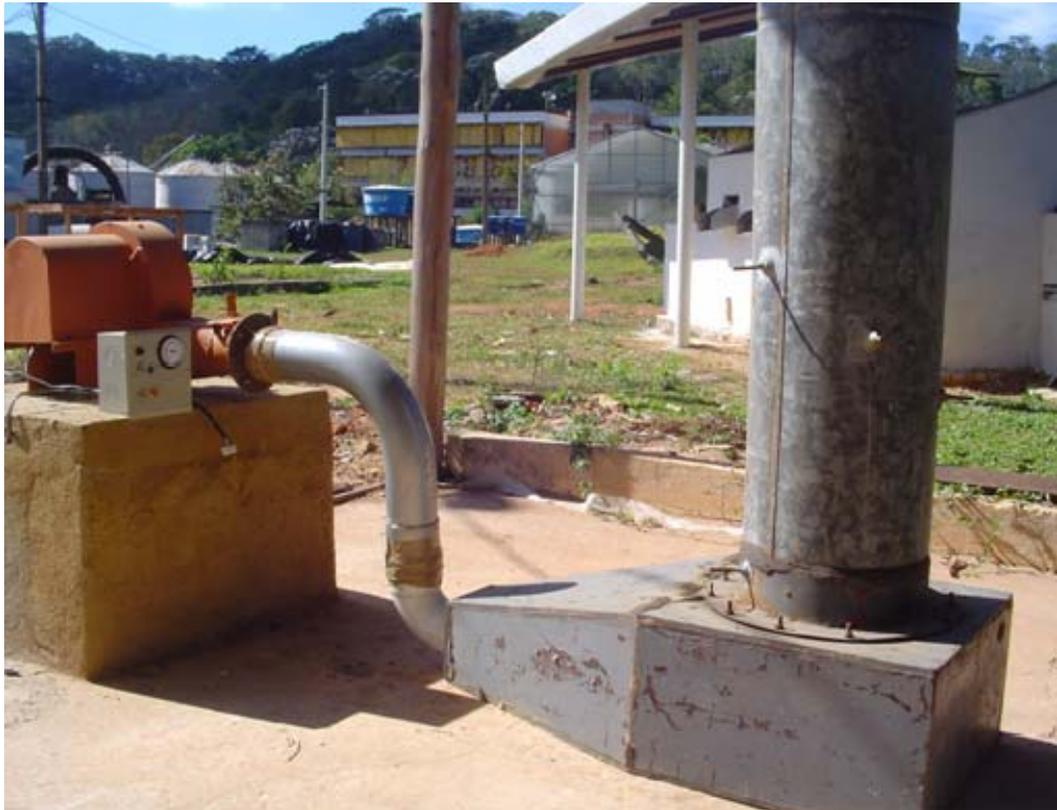
Figura 3.1. Equipamento utilizado na determinação do gradiente de pressão estática.
