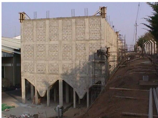
FIGURA 4 Construção do silo multicelular para café a granel, usando alvenaria estrutural, na cidade de Varginha, MG.
