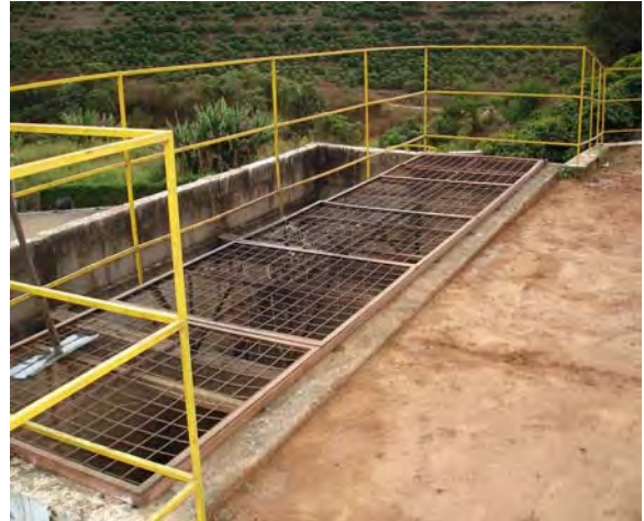
Figura 2 – Vista da grade metálica da moega receptora
