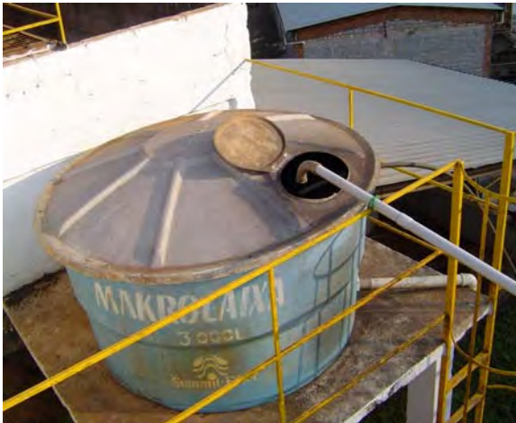
Figura 1 – Caixa d'água de abastecimento
