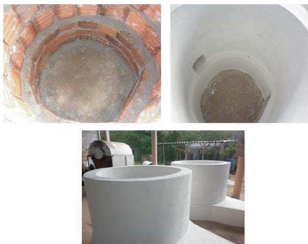
Figura 10 - Silos secadores de alvenaria.
