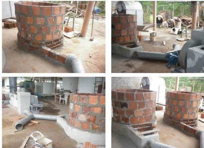
Figura 8 - Etapas de construção dos silos secadores e do acoplamento dos silos ao gaseificador.
