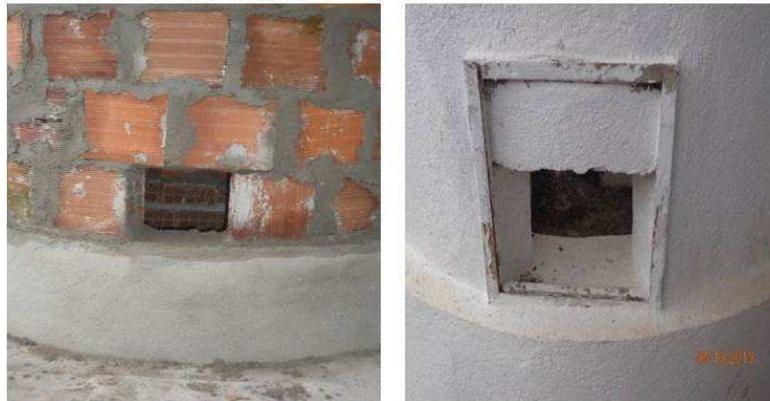
Figura 24 - Local de descarga do café seco nos silos.
