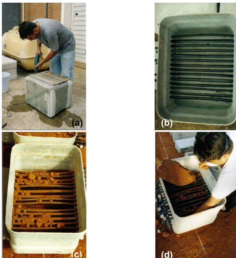
Figura 2 – Preparação dos vasos para recebimento das mudas: (a) furação das dos vasos; (b) instalação da 1ª linha de emissores; (c) preenchimento com solo; (c) Instalação da 2ª linha; (d) preenchimento com solo.
