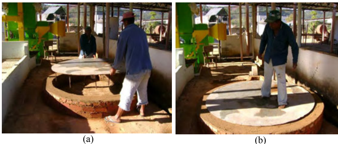
Figura 3.19 - Montagem da base do silo: (a) colocação do piso perfurado; (b) piso fixado, formando a câmara plênum .
