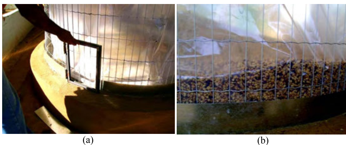
Figura 3.22 - Detalhes do silo secador-armazenador: (a) colocação da porta para descarga; (b) enchimento.
