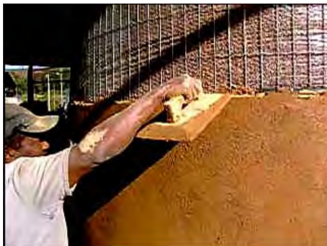
Figura 3.23 - Revestimento externo do silo secador–armazenador com argamassa.
