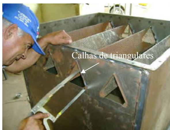
Figura 3.7 - Fixação das calhas triangulares no interior do módulo 3a.
