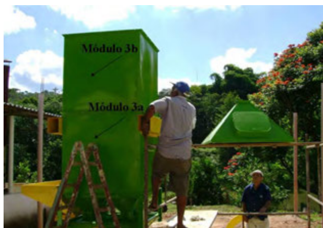
Figura 3.8 - Montagem dos módulos 3a e 3b.
