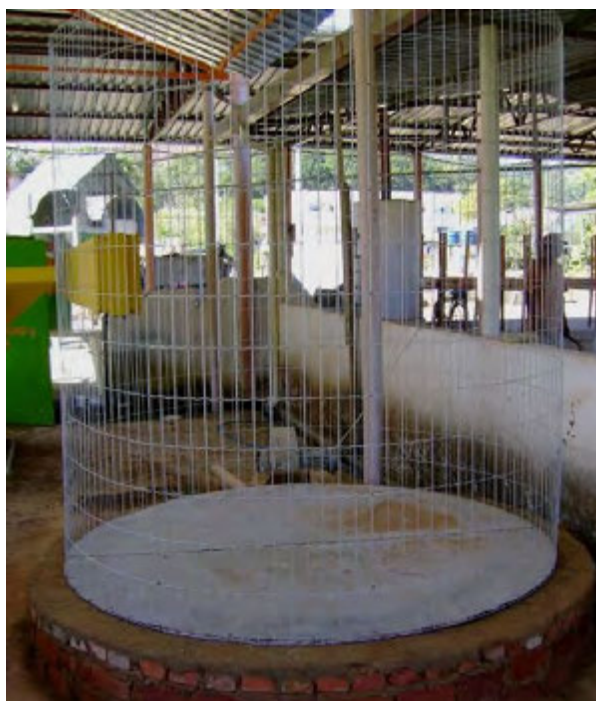
Figura 3.20 - Vista total da estrutura cilíndrica feita de tela de arame.
