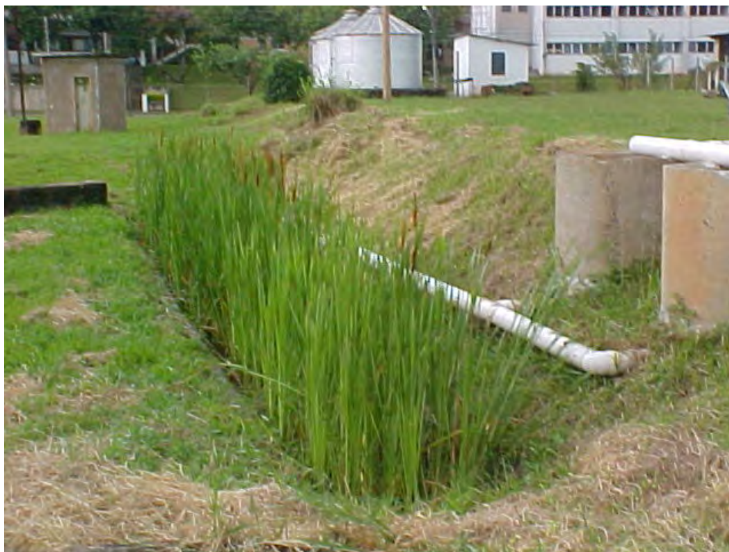
Figura 1.1. Vista geral do sistema alagado construído preparado para receber a ARC.
