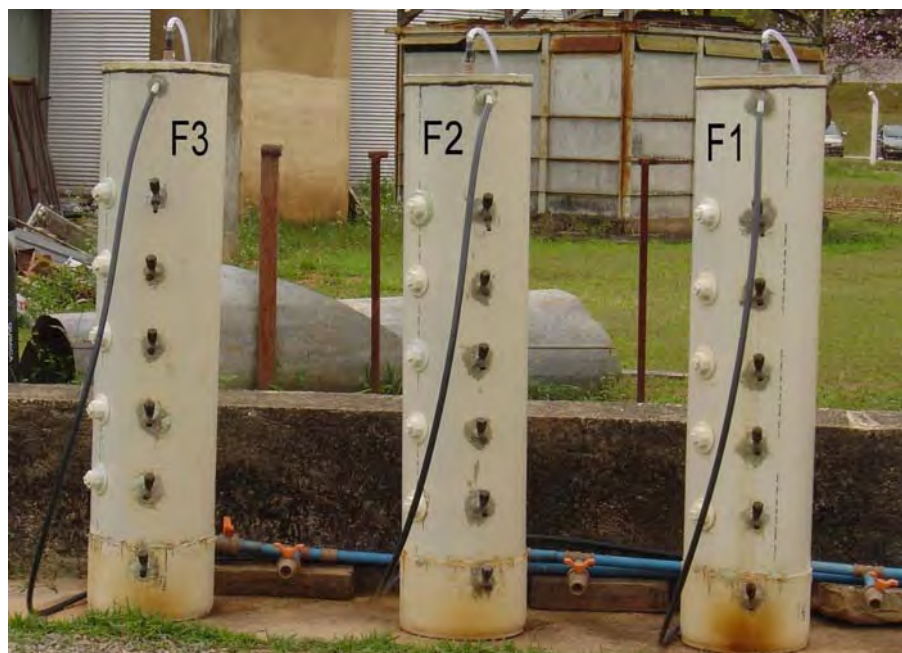
Figura 2.2. Vista dos filtros anaeróbios.
