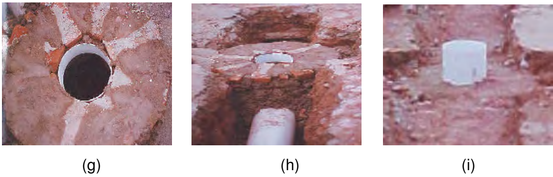
Figura 3 – (a) Vala para construção da tubulação do ar de secagem; (b) Concretagem do piso onde foi feita a caixa para o duto secundário; (c) Detalhe de construção da caixa; (d, e) Posicionamento das tubulações nas caixas; (f) Detalhe de fixação das tubulações nas caixas; (g, h) Conclusão da construção da caixa; (i) Aterramento e compactação da vala para concretagem do terreiro.
