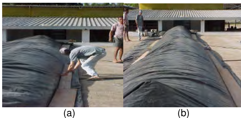
Figura 6 - (a) Cobertura da leira por causa das chuvas; (b) Sistema de ventilação em funcionamento.
