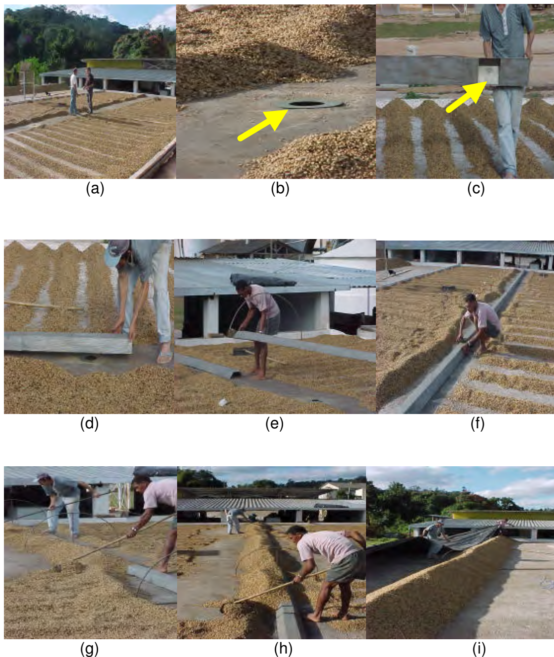
Figura 5 - (a) Vista geral do terreiro antes da montagem dos tubos de ventilação; (b) Detalhe da tomada de ar para o duto de ventilação; (c) Entrada de ar do duto; (d) Colocação do duto do sistema de ventilação; (e) e (f) Detalhes da montagem dos dutos de ventilação; (g) e (h) Detalhes da formação da leira; (i) Leira pronta para ser coberta.
