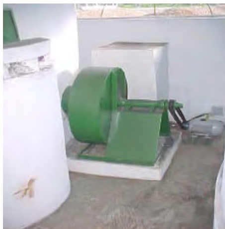
Figura 4 – Conjunto motor-ventilador.
