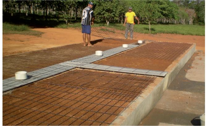
**Figura 15b.** Detalhes dos anéis de PVC para formação das tomadas de ar quente, antes de adicionar o concreto para formação do piso.
