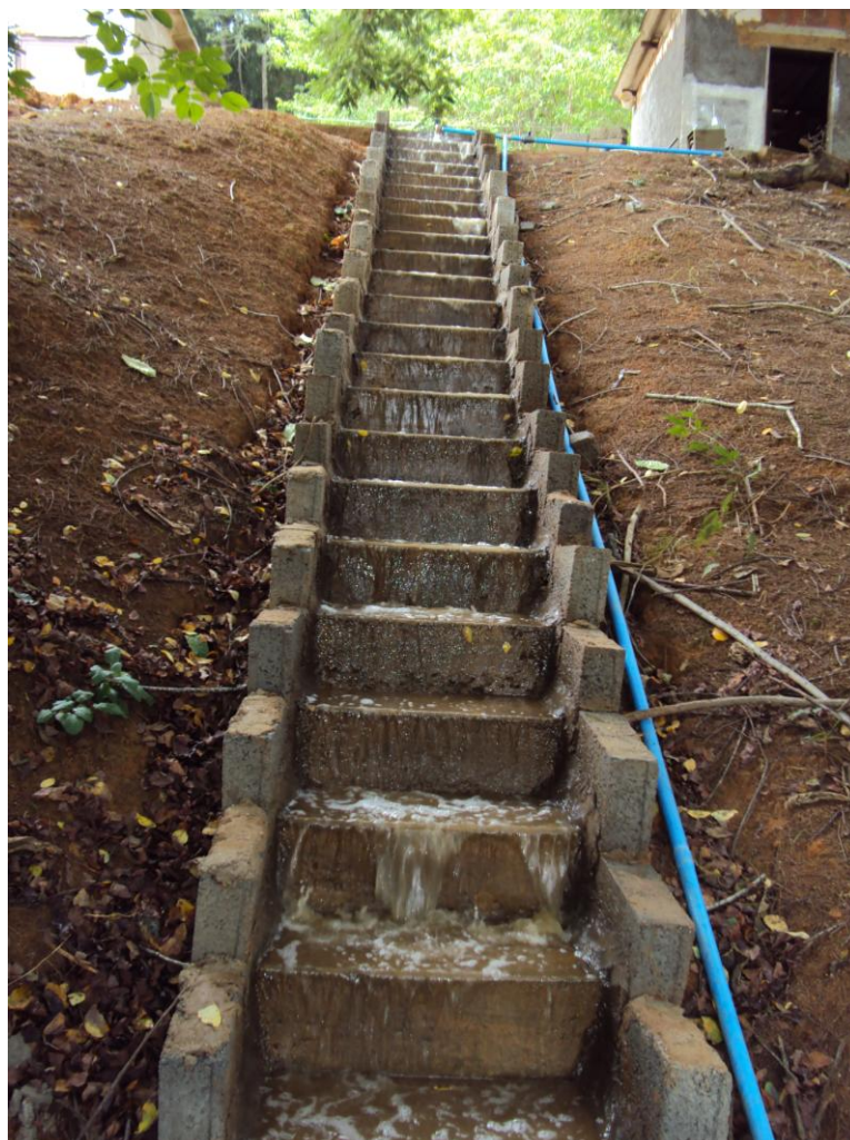
Figura 6. Detalhe do sistema em operação, por ocasião da recirculação da ARC na cascata.
