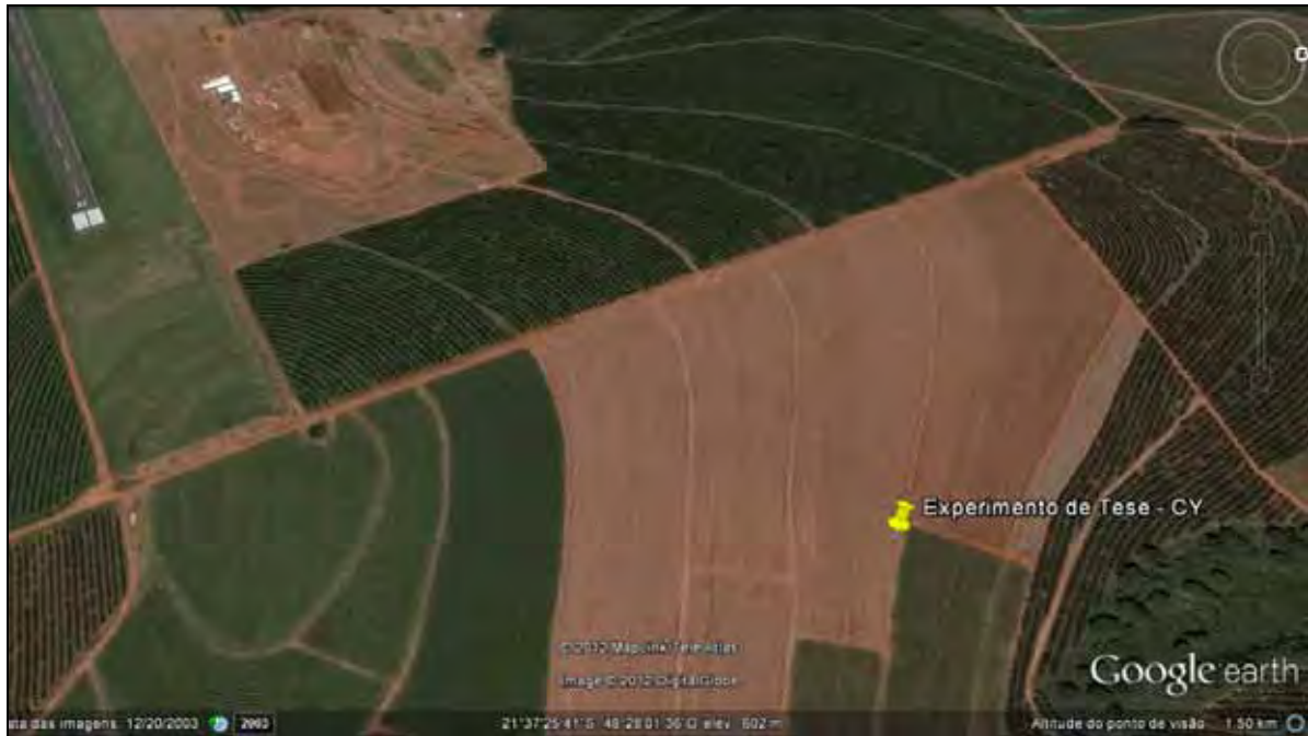
Figura 1. Vista panorâmica do local do experimento em dezembro de 2003 (Google Earth, 2012).
