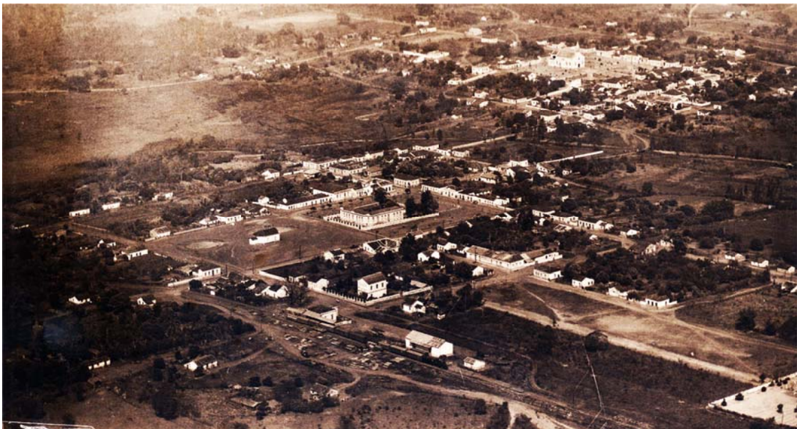
Vista de Boa Esperança do Sul – Coleção de Aerofotos Obliquas de 1939. Fonte Instituto Geográfico e Cartográfico do Estado de São Paulo.
