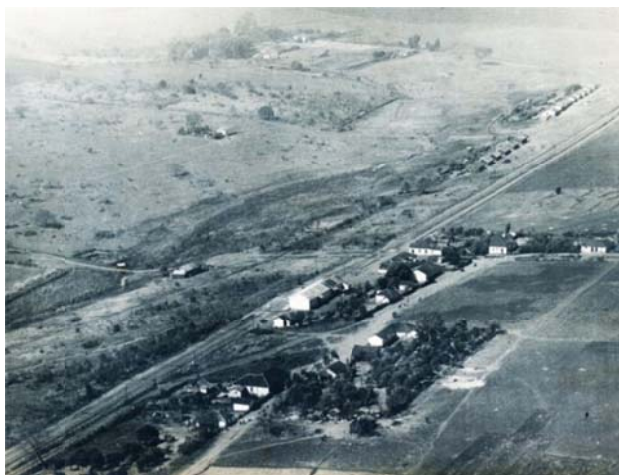
Vista de Pedra Branca – Coleção de Aerofotos Obliquas de 1939. Fonte Instituto Geográfico e Cartográfico do Estado de São Paulo.
