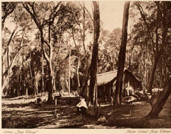
Casas de colonos em lotes rurais do núcleo colonial Jorge Tibiriçá – observar o uso das técnicas construtivas tradicionais como taipa de mão e a utilização de madeira roliça com cobertura em palha (1908). Fonte: Álbum vistas de São Paulo - Arquivo do Estado de São Paulo.
