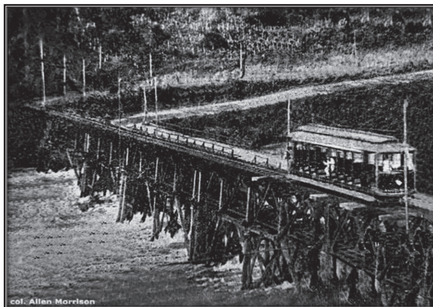
Figura 6 - Piraju: Ponte sobre o rio Paranapanema construído pela Iron Company , s/d. Fonte: Allen Morrison, 1984.
