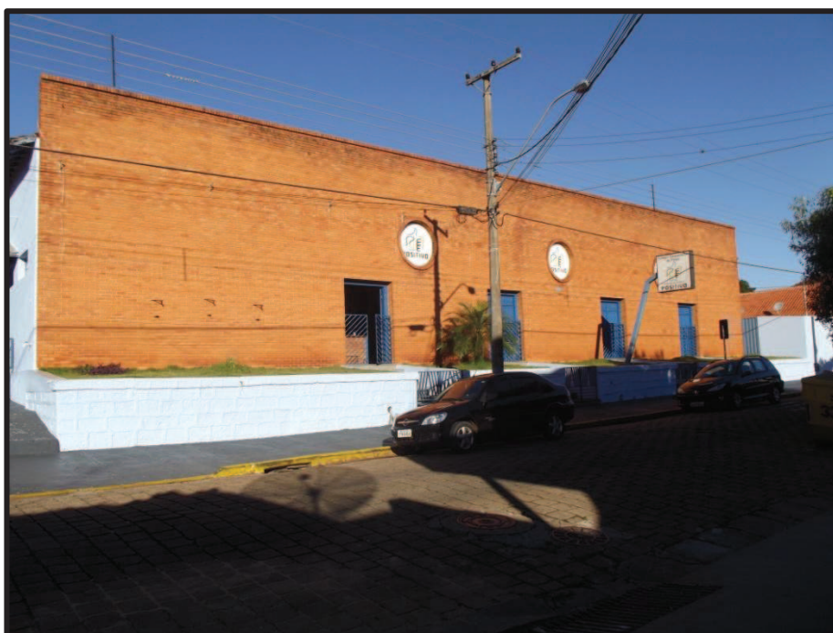
Figura 17 - Piraju: antigo prédio da Cooperativa dos Cafeicultores, 2012.
