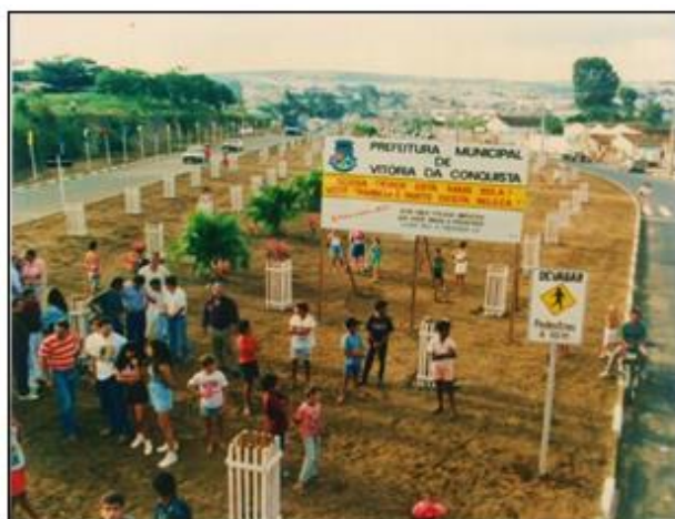
Figura 27: Duplicação da Avenida Bartolomeu de Gusmão, década de 1980
