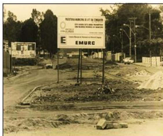
Figura 28: Pavimentação da Avenida Rosa Cruz, década de 1980
