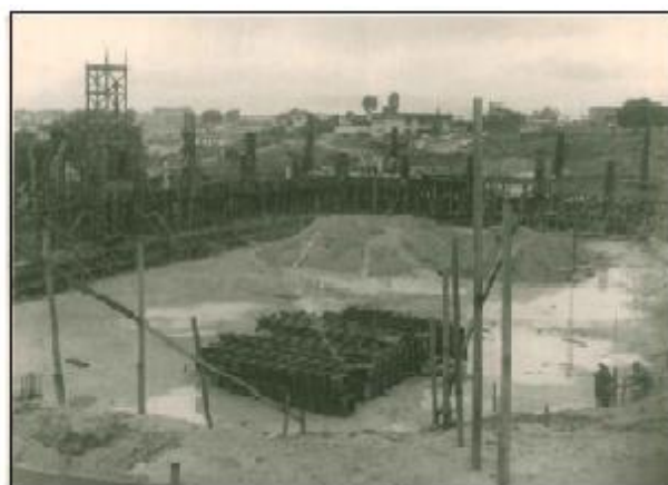
Figura 30: Construção do ginásio de esportes Raul Ferraz, década de 1980
