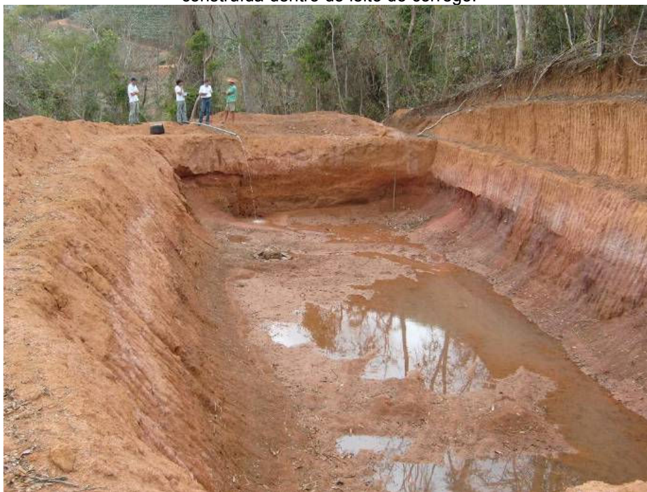
Figura 43 – Estruturas de reservação de água em partes altas da bacia do Sossego.
