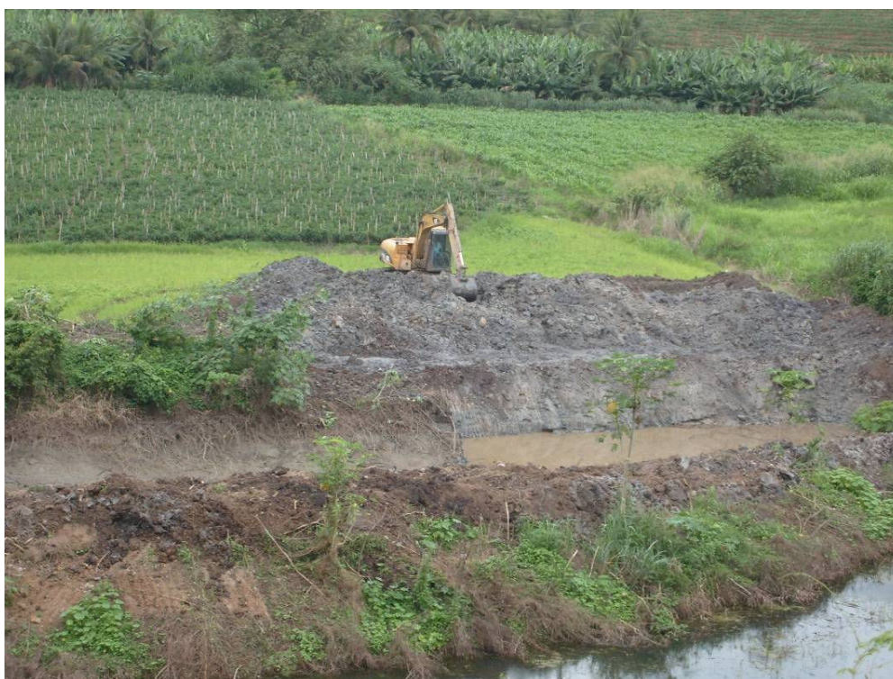
Figura 44 – Poços escavados na bacia do Sossego. Detalhe, na foto inferior, para a escavação de mais um poço no fim do ano de 2010.
